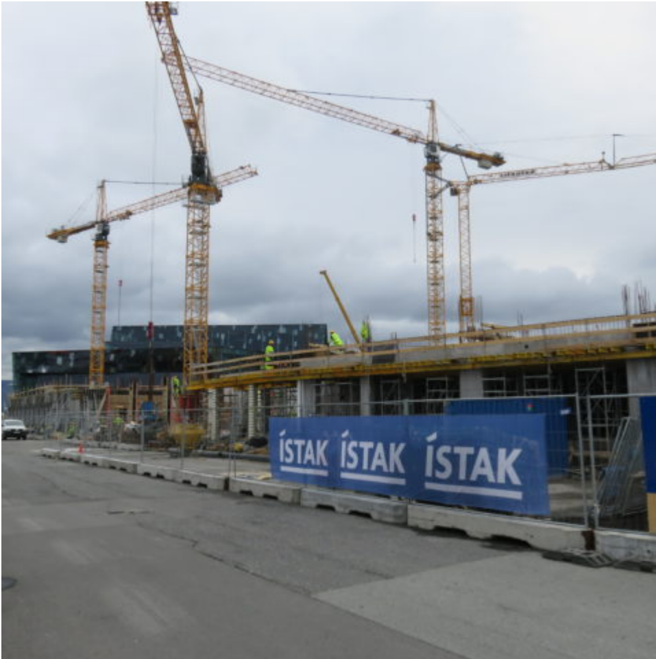
Austurbakki 2, reitur 5b. 2ja hæða bílakjallari, verslanir og 70 íbúðir Work in progress
