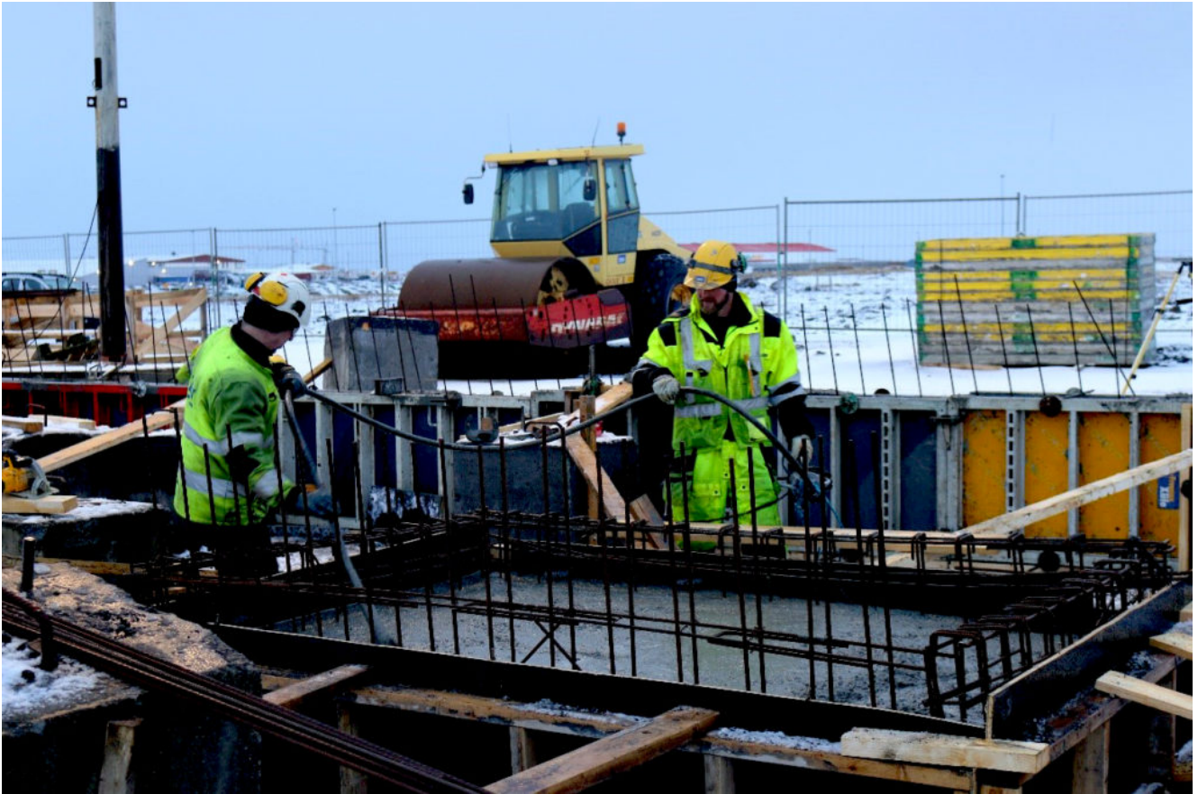
Grétar verkstjóri og Guðmundur að leggja lokahönd á steypa lyftugryfju í skrifstofubyggingu
