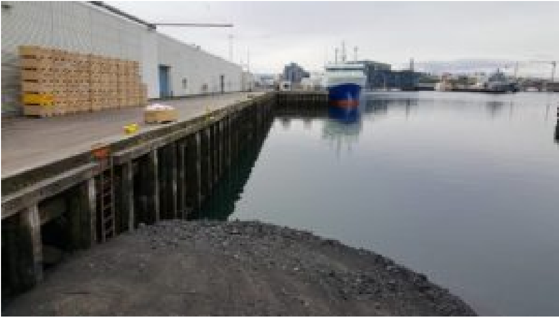
Svona leit hafnarbakkinn út áður en framkvæmdir hófust.
