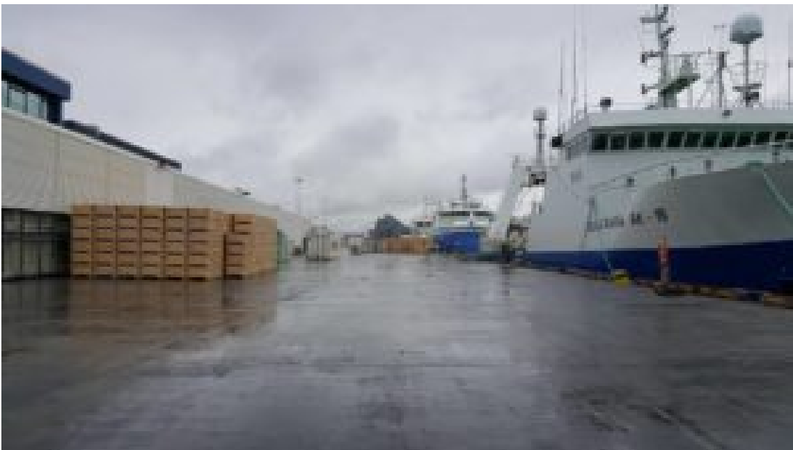
Að loknum framkvæmdum.
