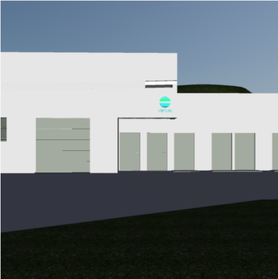
Vetrarbraut dælustöð Verk í vinnslu
